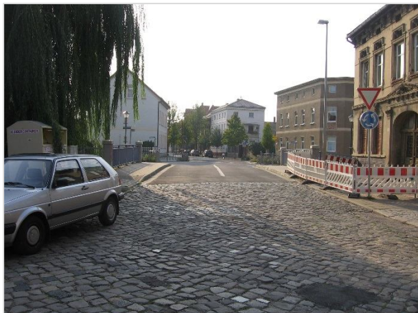
Unterm Hagen Höhe Bergstraße Blickrichtung Westen
