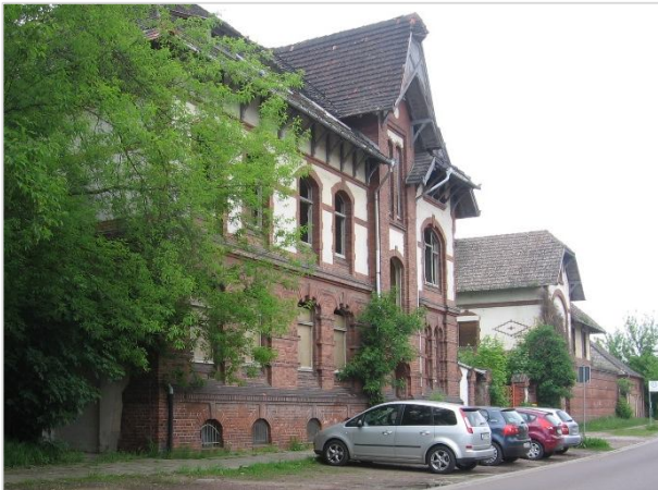
Gebäude des ehemaligen Schlachthofes an der Blumenthaler Landstraße
