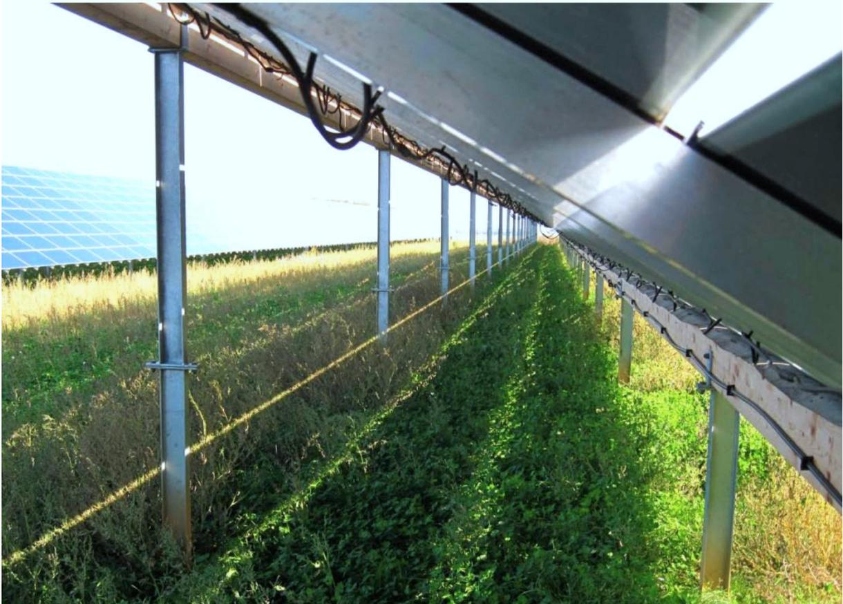
Abb. 1: Durchlässigkeit des Modultisches für Regenwasser
