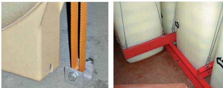
**Abbildung 13: Sicherung von Heizöltanks [aus BVBS, 2006]**
