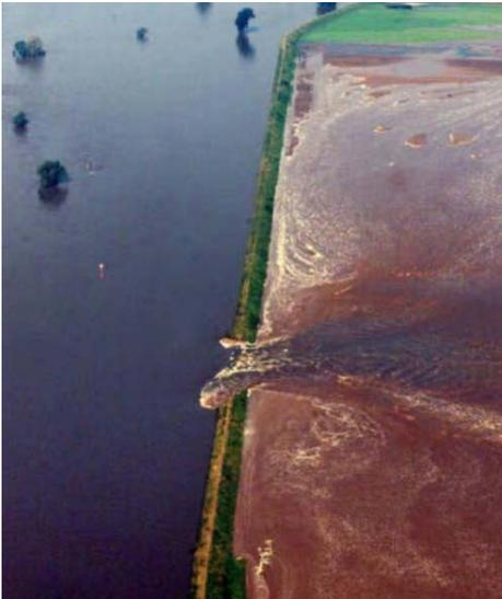
**Abbildung 5: Deichbruch bei Dautzschen (unterhalb von Torgau) am 18.08.2002, Elbe [aus IKSE, 2004]**
